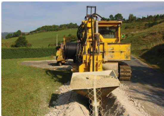
Photo 124 : La pose d'un câble souterrain depuis le poste de livraison jusqu'au réseau électrique public
