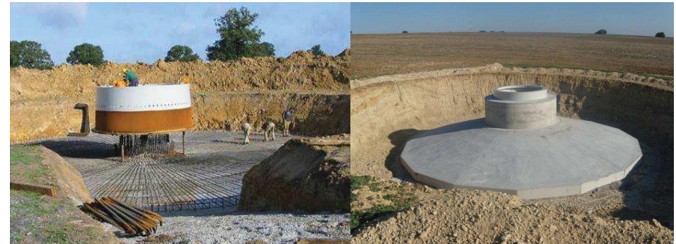
Photo 119 : Le ferrailage et le coulage d'une fondation d'éolienne
