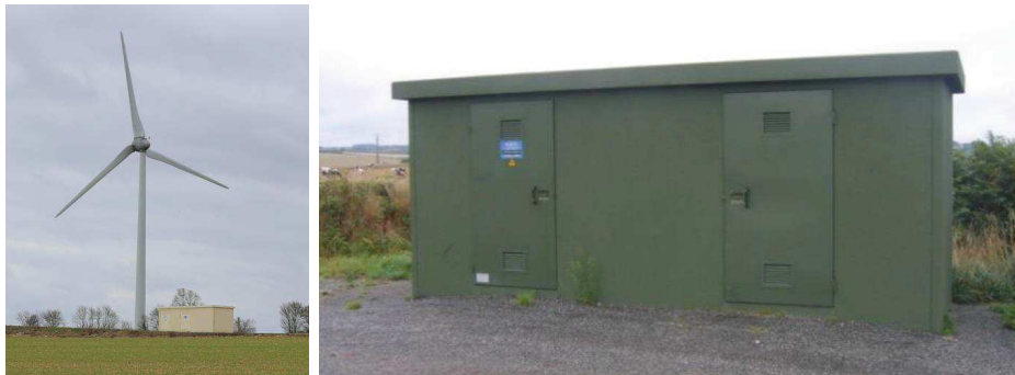
Photo 123 : Exemples de poste de livraison électrique
