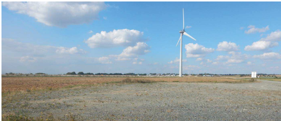
Photo 120 : Un exemple d'aire de grutage depuis le pied d'une éolienne
