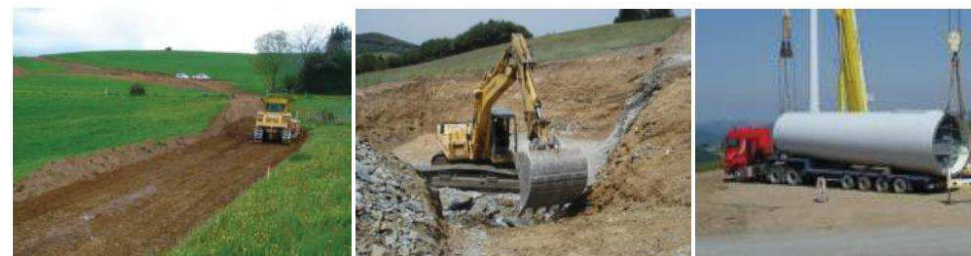
Photo 129 : Illustrations d'un chantier éolien.
