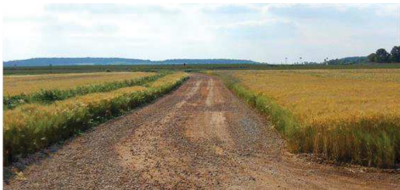
Photo 121 : Un exemple de voie d'accès à un parc éolien en milieu agricole
